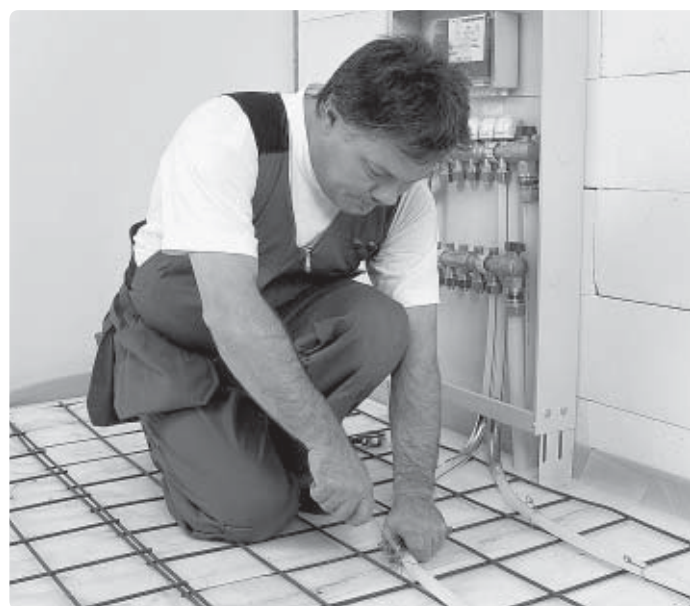
Golvvärmerör najas mot armeringsjäm
